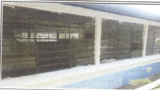
Foto 2: reposicion de Ventanas/ modulo I
