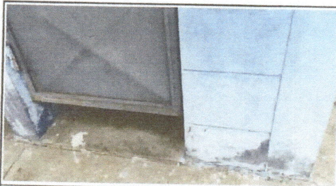
Foto 4: cambio de puertas de baños/ modulo III
