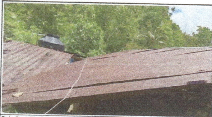
Foto 3: cubierta de lamina/ modulo II
