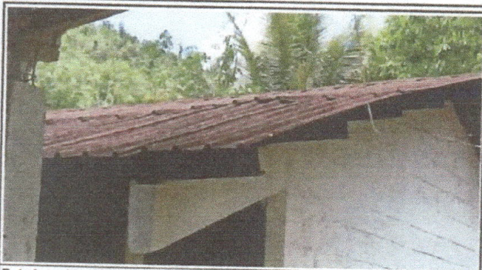
Foto 1: cubierta de lamina/ módulo I
